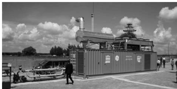
Рис. 3. Бориспільська станція переробки звалищного біогазу в електроенергію потужністю 1 МВт
